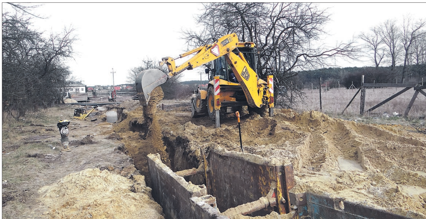
Prace przy ul. Zielonej rozpoczęły się od modernizacji sieci wod-kan
