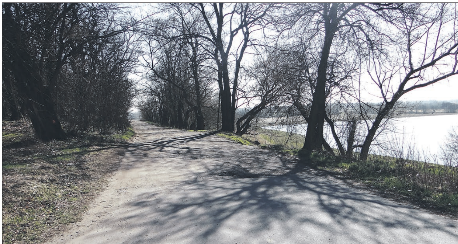
Gruntowa nawierzchnia w Górze Bałdrzychowskiej Kolonii zostanie utwardzona
